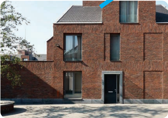
Muren als afronding bouwblokken
